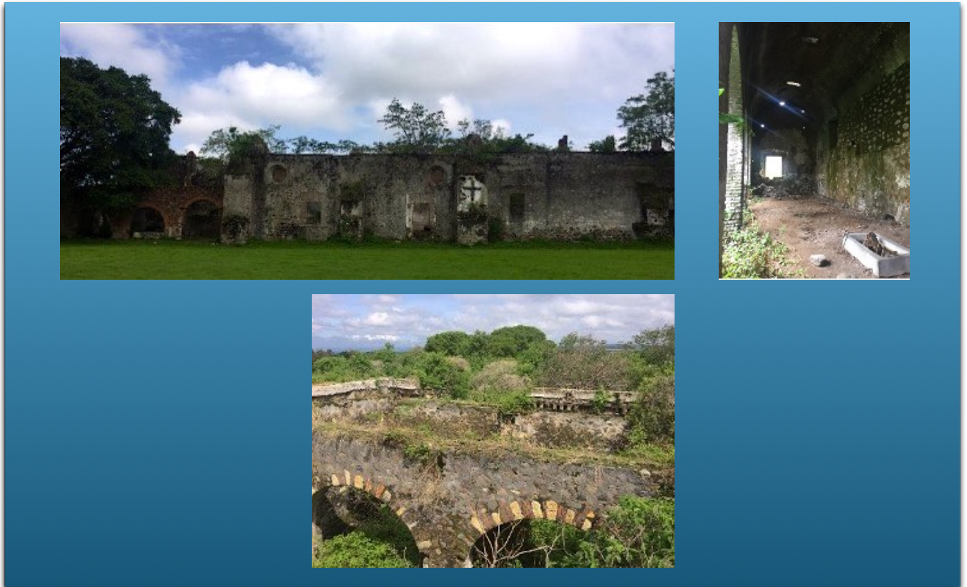
Fig. 05.-Imágenes del abandono y deterioro, situación de las haciendas en el Estado de Morelos sin plan de conservación. (MAC, 2021)
