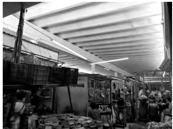
IMAGEN 6. Vista del área de legumbres y verduras del Mercado Municipal núm. 1, el cual cuenta con cubierta de trabelosas pretensadas de concreto armado. Fuente: Diario de Yucatán , 1 de febrero de 1965, p. 8.
