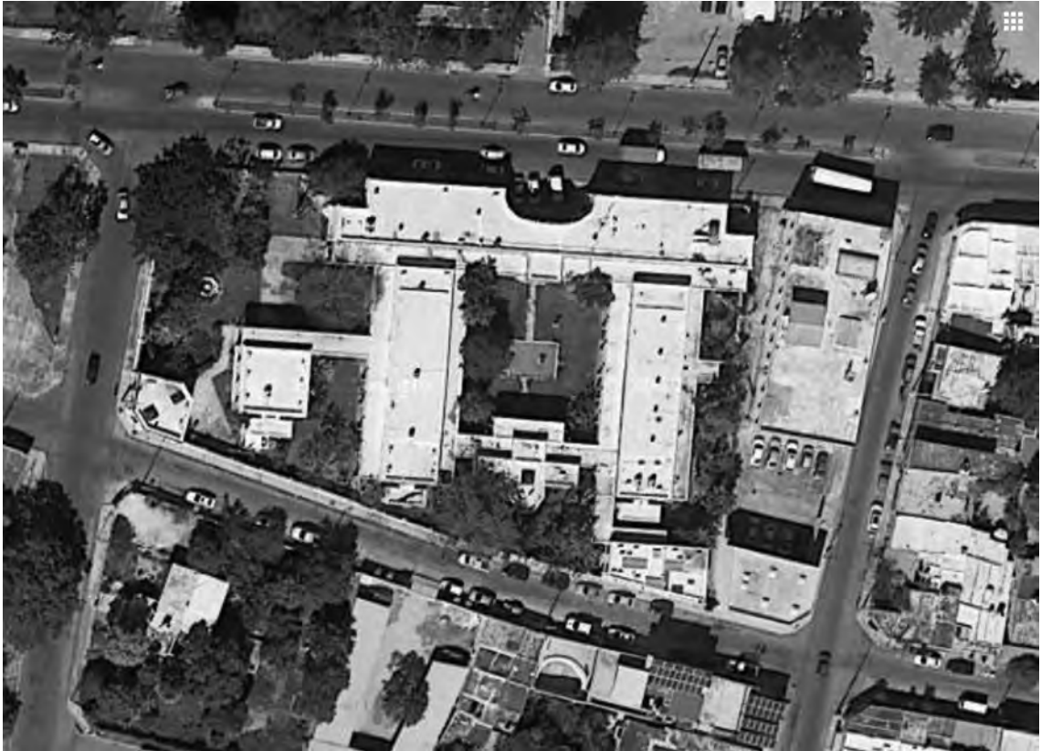
IMAGEN 6. Vista aérea actual del Sanatorio Rendón Peniche; sede actual del CEPHCIS-UNAM. Fuente: Google Maps, Alphabet Inc., 2019.
