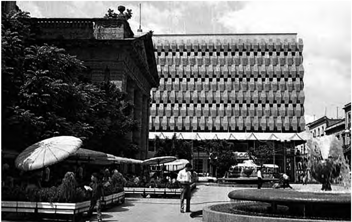
IMAGEN 2. Edificio Franco. Fuente: El Informador , 18 de abril de 1947.
