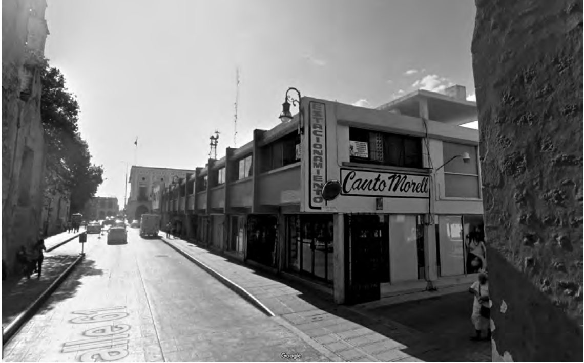
FIGURA 6. Locales comerciales y oficinas de estilo funcionalista en la calle 61.
