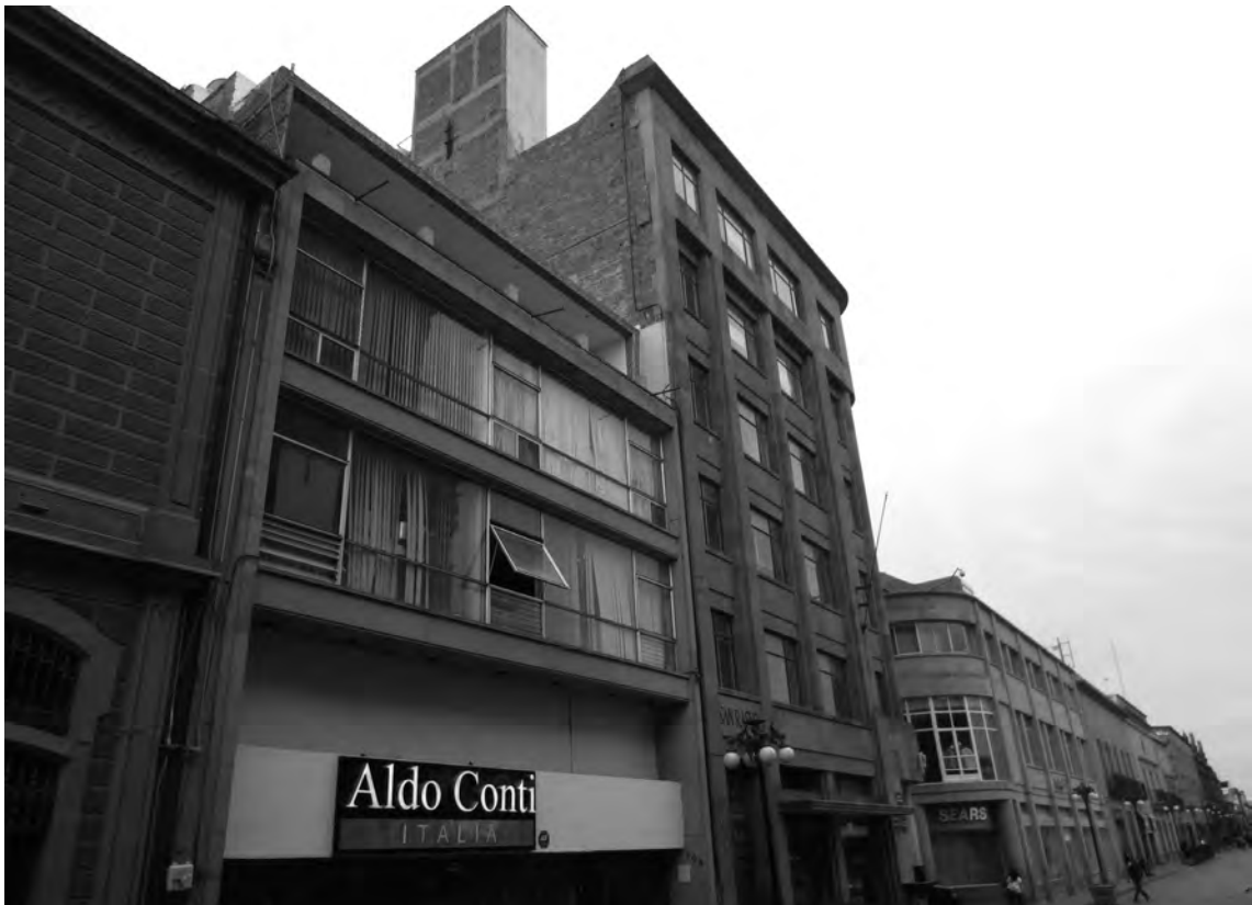
IMAGEN 8. Edificio Jolzan. Fotografía: Jesús Villar Rubio, 2019.
