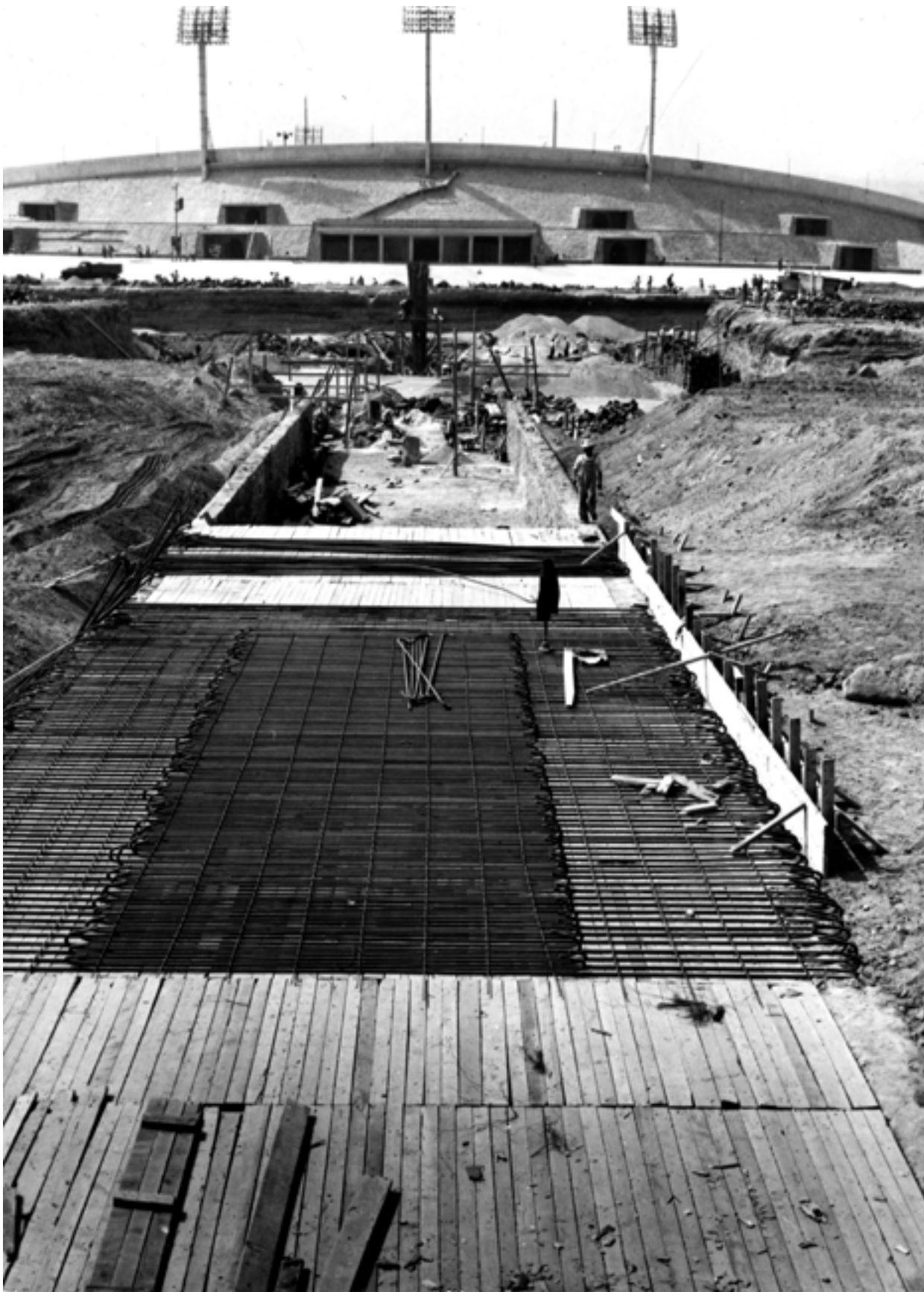
Construcción de Ciudad Universitaria, paso a desnivel de la Torre de Rectoría al Estadio Olímpico Universitario, fotografía de Saúl Molina Barbosa, ca. 1952, Archivo Fotográfico Manuel Toussaint, Instituto de Investigaciones Estéticas, UNAM
