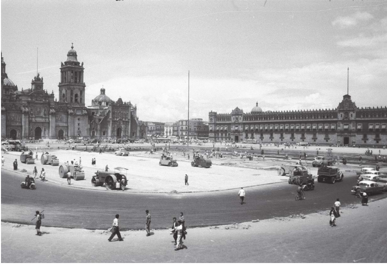
Fotografía 15. Obras en el Zócalo, 1958, agosto 22, fotografía anónima, 1958
