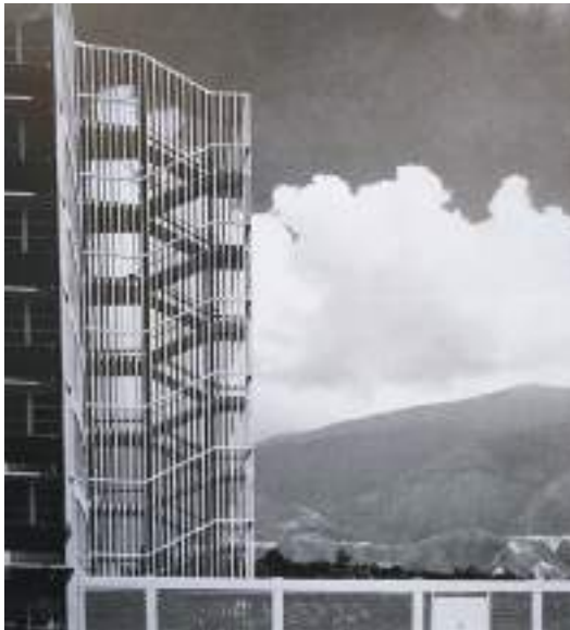
Imagen 9: Torre de escaleras, Escuela de Farmacia. Ciudad Universitaria de Caracas
